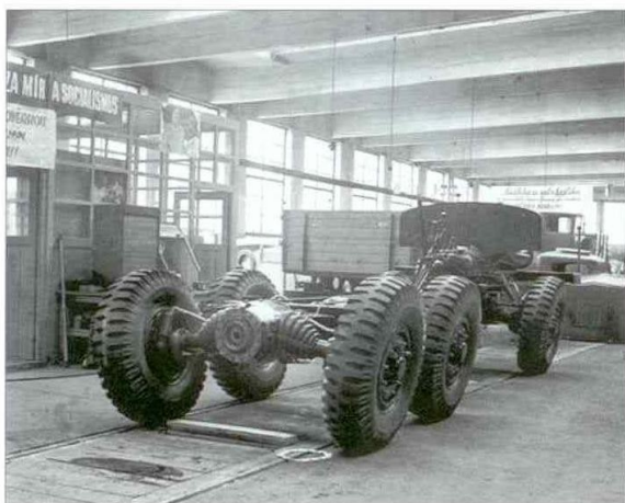
Podvozek Tatra 130 při montáži vozu. Ze snímku je patrná velká světlá výška
